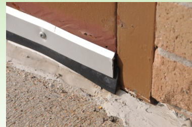
Replace broken door sweeps
